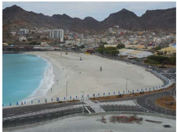
A praia da Laginha em Abril de 2014 / Zone completion of the work
