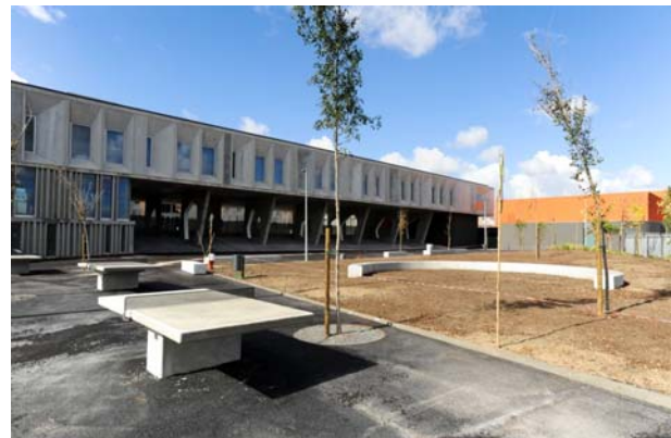
Vista geral dos edifícios da escola
