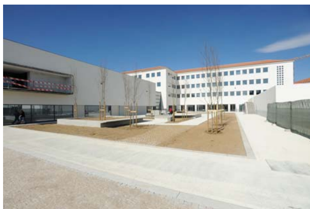
Vista parcial dos edifícios e arranjos exteriores
