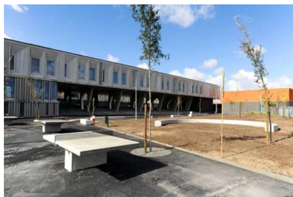
Vista geral dos edifícios da escola
