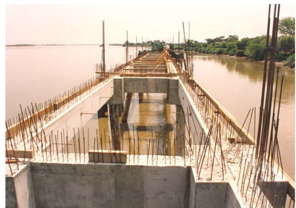
Estacas, encabeçamentos e passadiços metálicos (em cima) Cais acostável durante a fase da sua construção (em baixo) Piles and capping structures and steel structures (top view) Berthing Quay during construction phase (bottom view)
