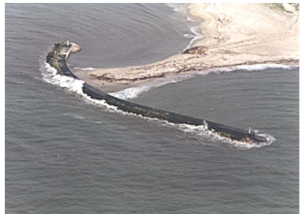
Quebra-mar destacado - Castelo do Neiva Outlying breakwater - Castelo do Neiva
