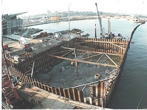
Ensecadeira da eclusa Lock cofferdam
