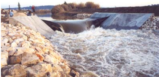
Açude das Salgadas: vista de jusante da margem direita (açude a descarregar com o insuflável a esvaziar)
