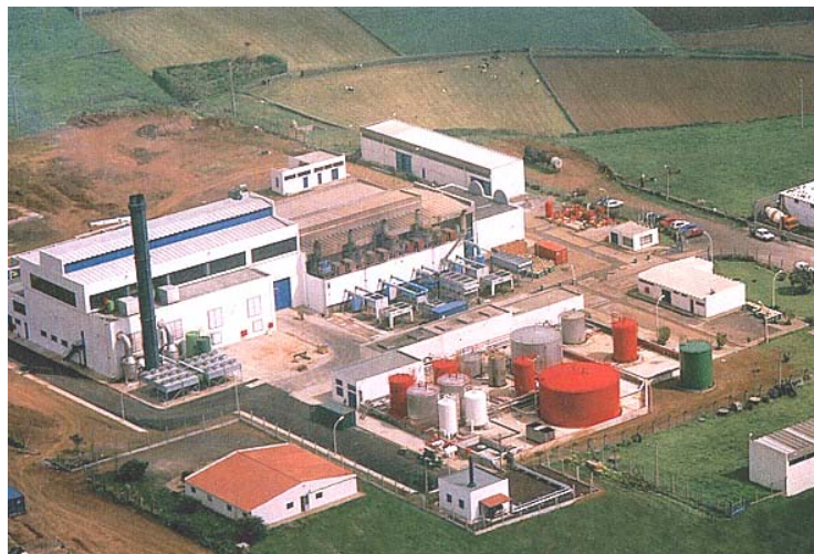
Vista aérea da central termoeléctrica de Bejo Jardim À esquerda o edifício da nova ampliação. Em primeiro plano, o novo parque de combustíveis.
