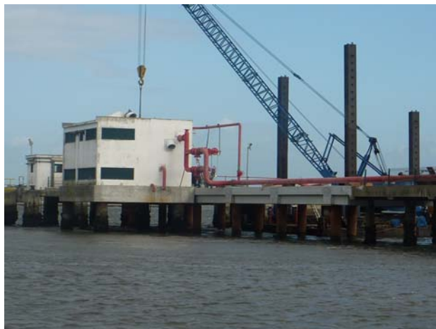
Depois de concluídos os trabalhos de reabilitação After concluded the rehabilitation works
