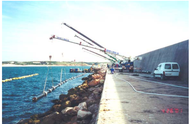
Lançamento da tubagem (topo). Vista durante a construção (em baixo). Pipe launching (top). Construction in progress (below).
