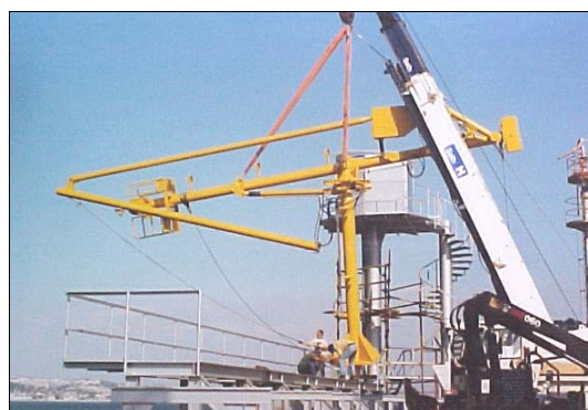
Em baixo: Montagem de um dos braços de carga. Bottom: Erection of one the loading arms.
