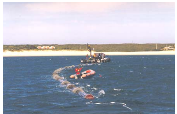
Lançamento da tubagem (topo). Vista durante a construção (em baixo). Pipe launching (top). Construction in progress (below).
