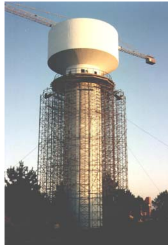
Aspecto das torres de escoramento.
