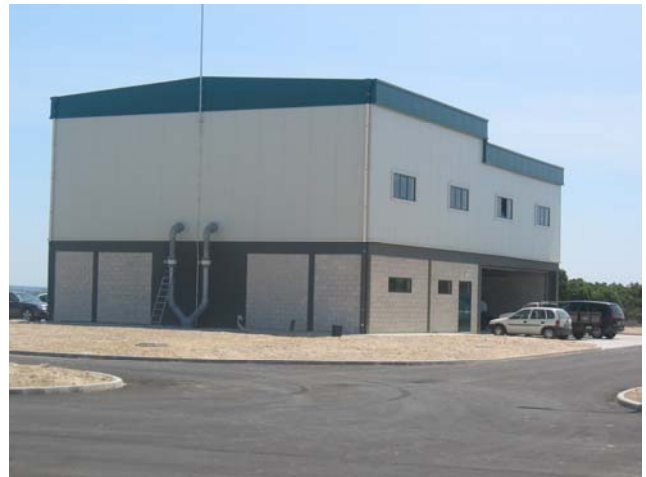
Vista do edifício de tratamento de águas residuais View of WTP building
