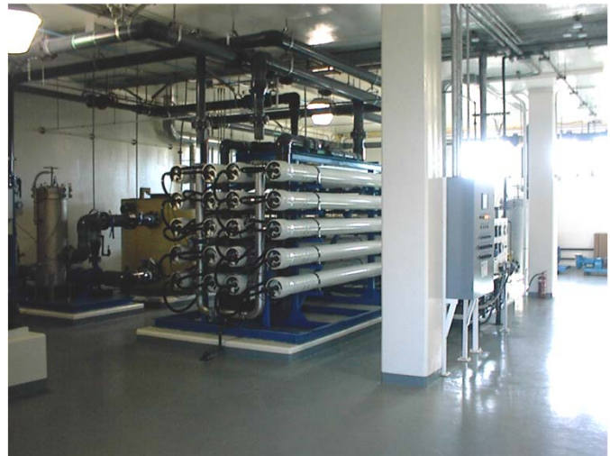
Baterias de membranas Membrane stacks
