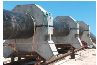
Lançamento da tubagem e vista durante a construção. Pipe launching and Construction in progress.
