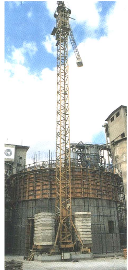
Aspecto da armadura do cone de descarga. Densidade de aço: 190 kg/m 3
