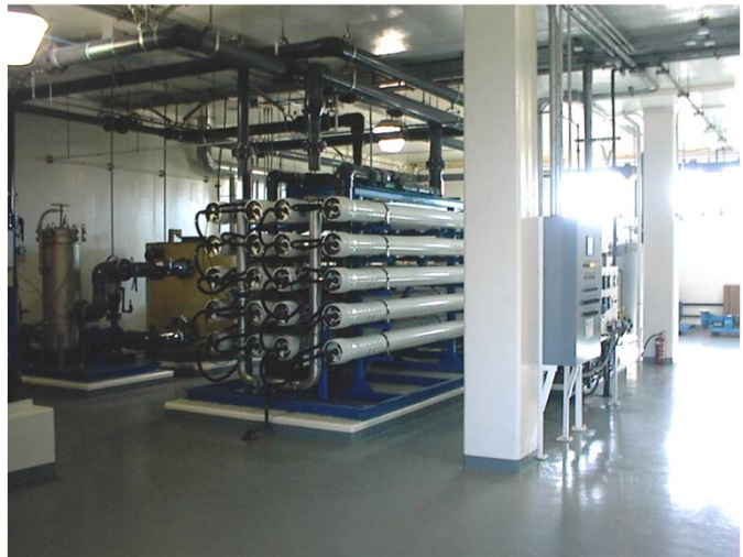
Baterias de membranas Membrane stacks
