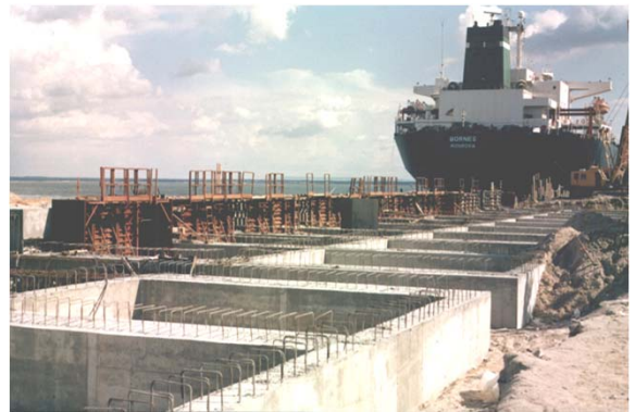
Aspecto dos trabalhos de ampliação do Cais 3 General view of the Pier 3 Extension works
