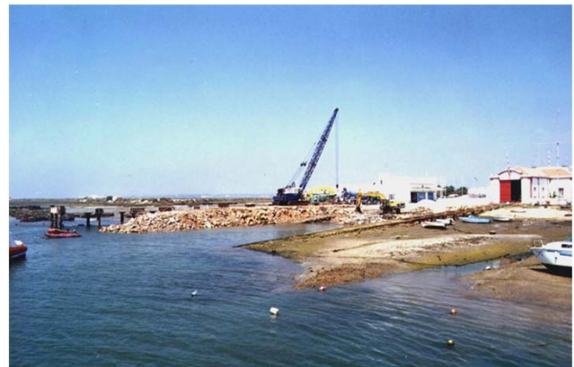
Topo: aspecto, após a conclusão Top: view, after completion
