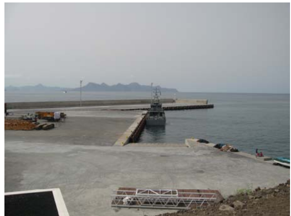
Zona dos cais de acostagem após conclusão da obra Zone of berths after completion of the work
