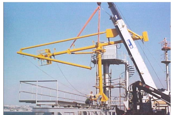
Em baixo: Montagem de um dos braços de carga. Bottom: Erection of one the loading arms.
