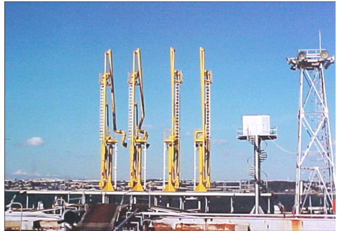
Em cima: Vista dos braços de carga, após a montagem Top: The loading arms after assembly and erection.
