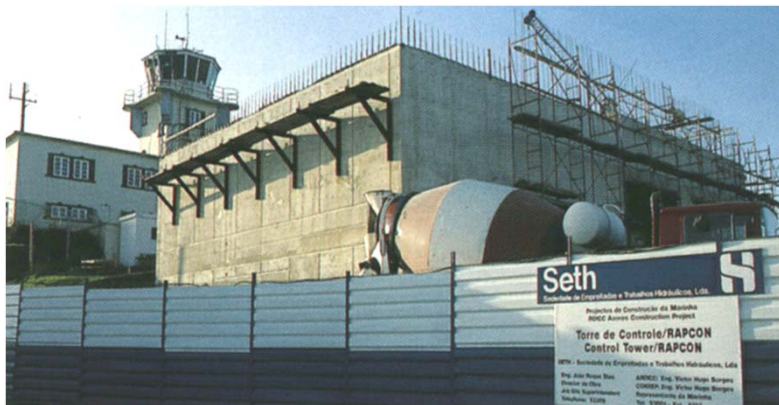
Aspecto da betonagem do paramento exterior.
