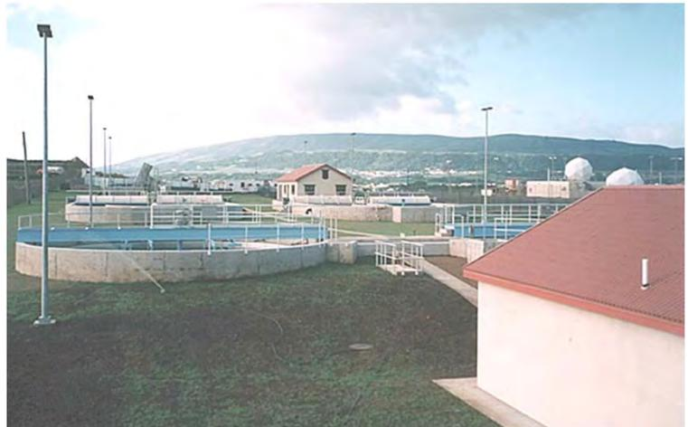
Vista geral da ETAR. Em segundo plano, os tanques de clarificação
