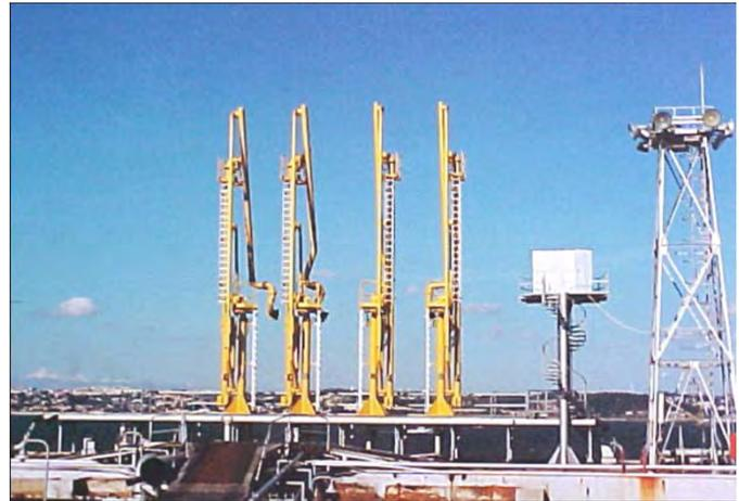
Em cima: Vista dos braços de carga, após a montagem
