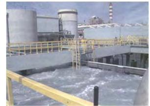
2 Tanques de reacção biológica (50x 25x8 m) / *Biological reaction tanks (50x 25x8 m)*
