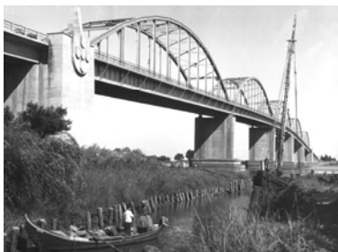
Ponte Marechal Carmona Construída pela SETH em 1951
