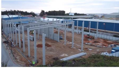
Estruturas de betão
