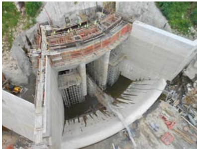
Barragem de Salamonde (trabalhos na zona Restituição Albufeira da Caniçada)
