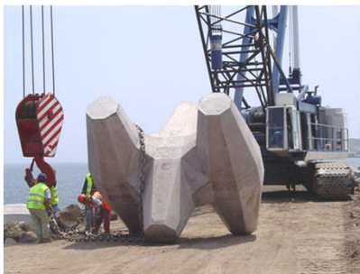
Core-Loc® 33 ton Quebra-Mar Porto da Praia da Vitória, Terceira (os maiores Core-Loc® do mundo)
