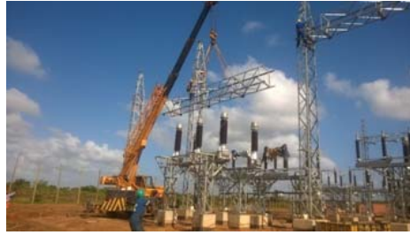
Transmissão e Distribuição de Energia (MT, AT, MAT) Trabalhos de electrificação em Moçambique
