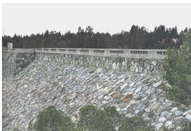
Barragem do Vale do Gaio Construída pela SETH em 1949
